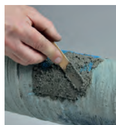
Utgjämna betongskiktet och låt det torka.
