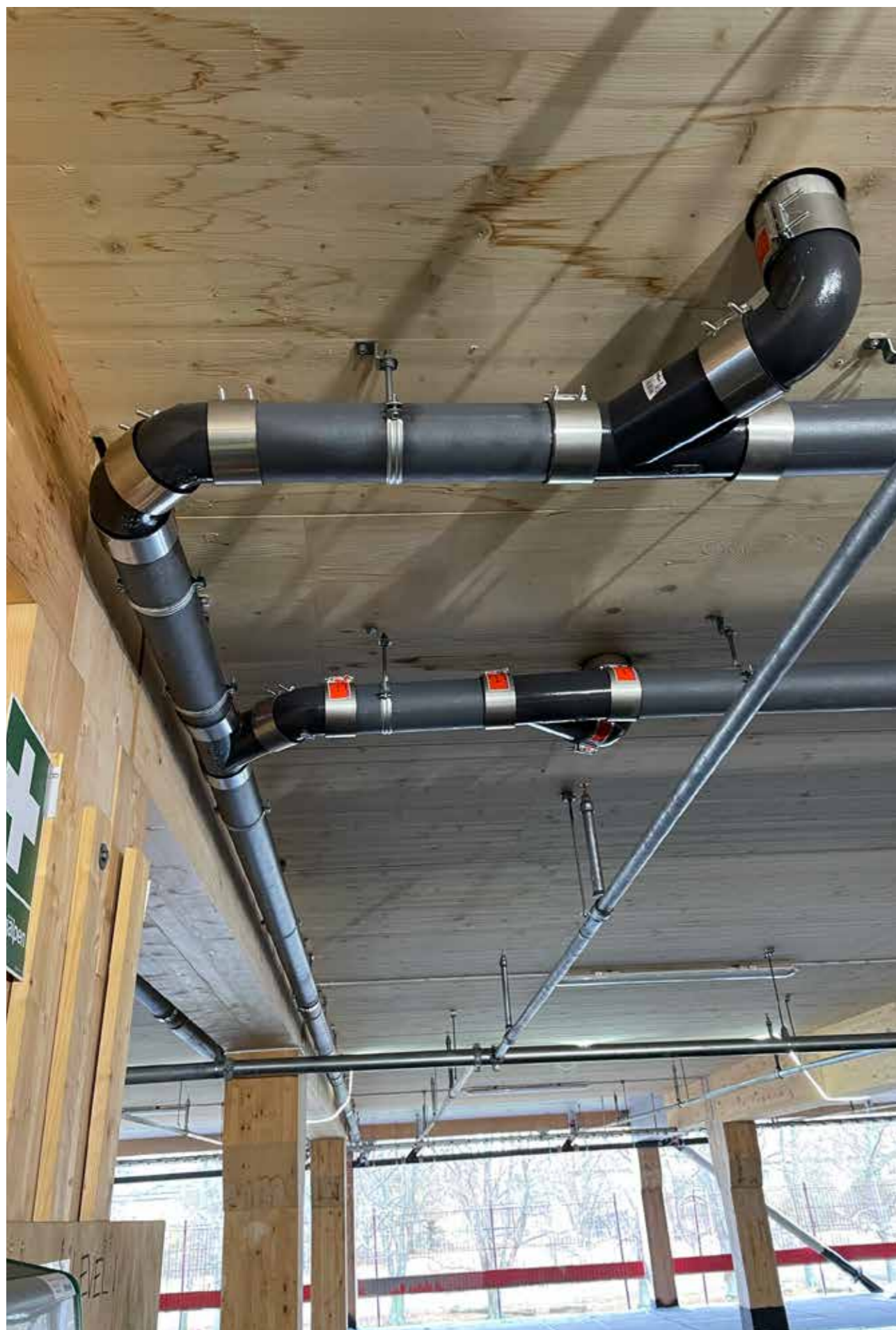
I parkeringshuset har man valt att installera MA-SYSTEM® PLUS både i stammar och liggande ledningar i DN100 mm.
