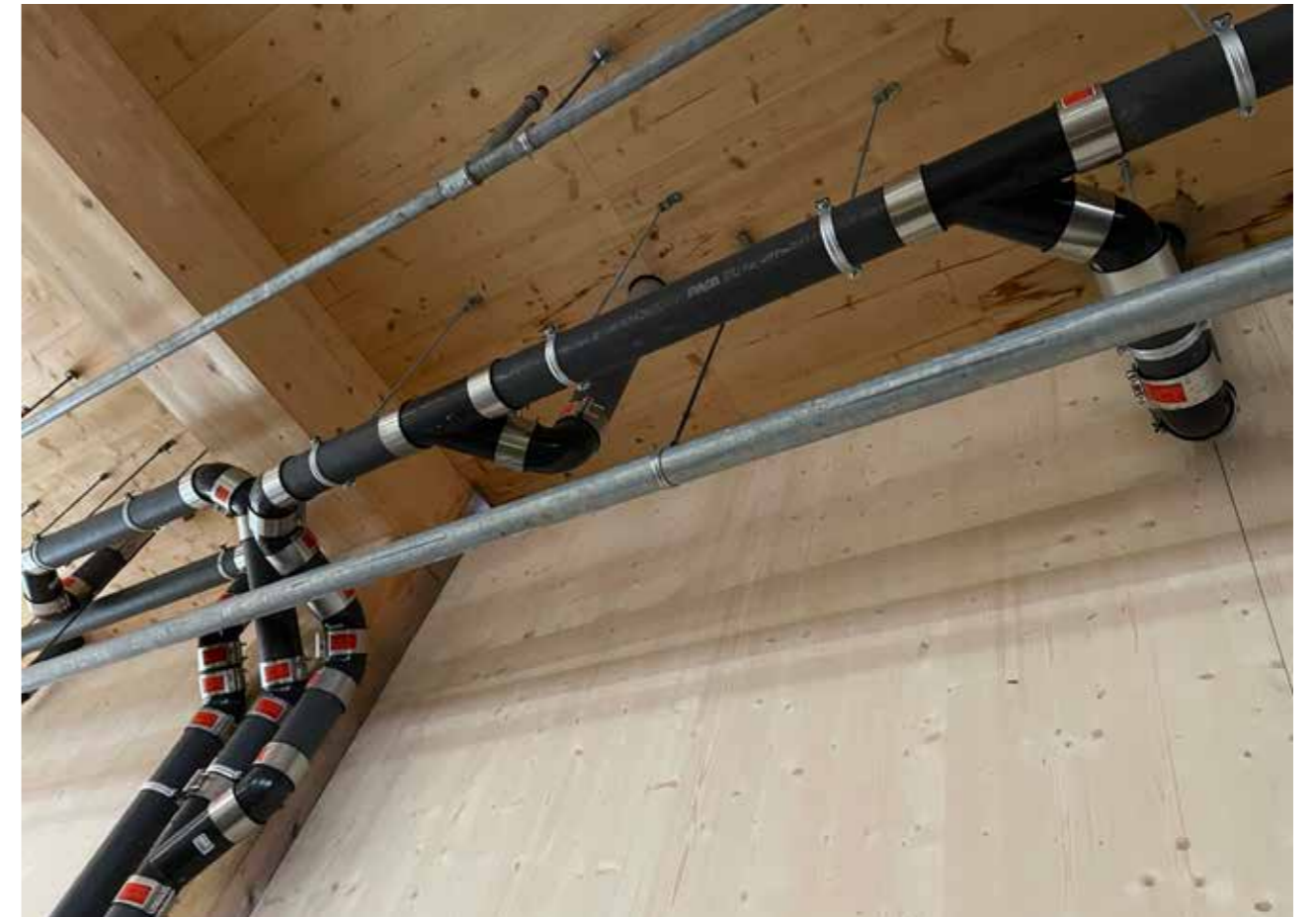
Systemet monteras med klamsvep som fästes i taket
