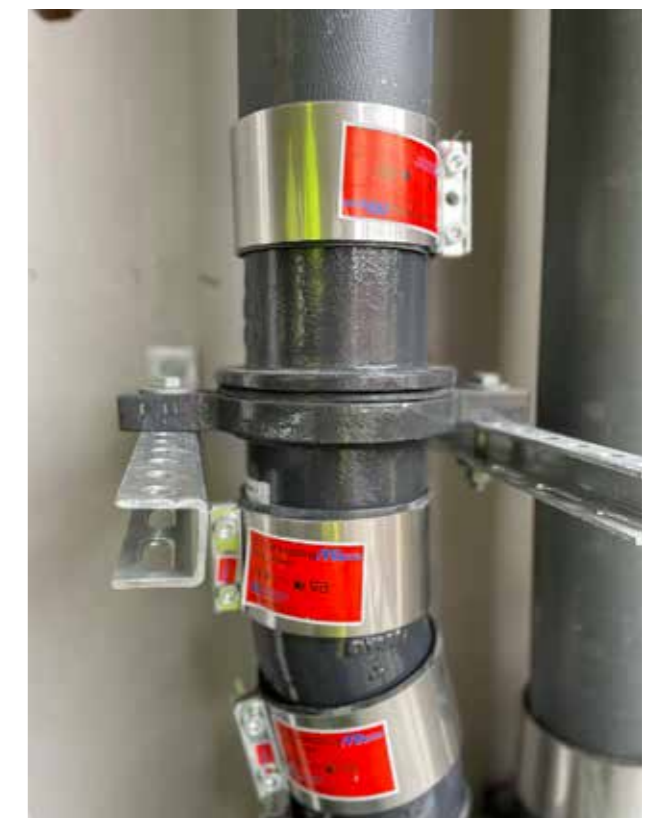
För att fixera och avlasta systemet monteras MA-SYSTEM® PLUS Stamrörsstöd. Vi rekommenderar att stödet monteras på var tredje våning.
