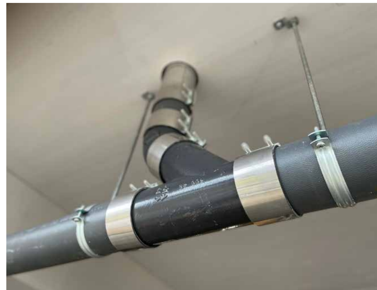
Rör och rördelar har en ytbehandling i flera skikt som effektivt skyddar systemet. Rören har även en zinkbeläggning som verkar aktivt och ger självläkande egenskaper.
