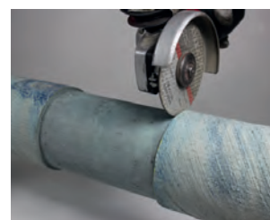
Kapa och fasa därefter röret med de verktyg och maskiner du normalt använder.
