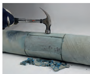
Genom att knacka med en penhammare eller motsvarande kan betongen nu avlägsnas.
