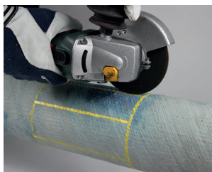
Skär med vinkelslip alternativt använd vass plattmejsel för att knacka igenom betongen runt om samt längs med röret på den yta som skall friläggas.
