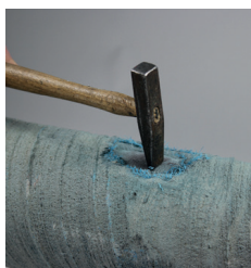
Rensa skadan från lössittande betong.
