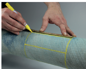
Markera runt om samt längs med röret den yta som skall friläggas. Följ nedanstående tabell vad gäller den längd på vilken betongen skall avlägsnas.
