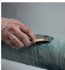
Blanda och lägg på betong i och runt om skadan.
