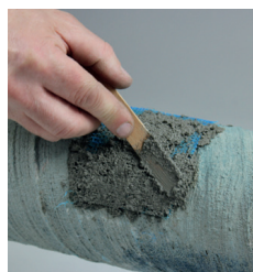
Utgjörna betongskiktet och låt det torka.
