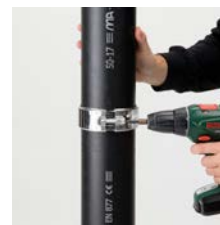
Dra ihop med skruvdragare alt. spärrnyckel (6 mm insex).
