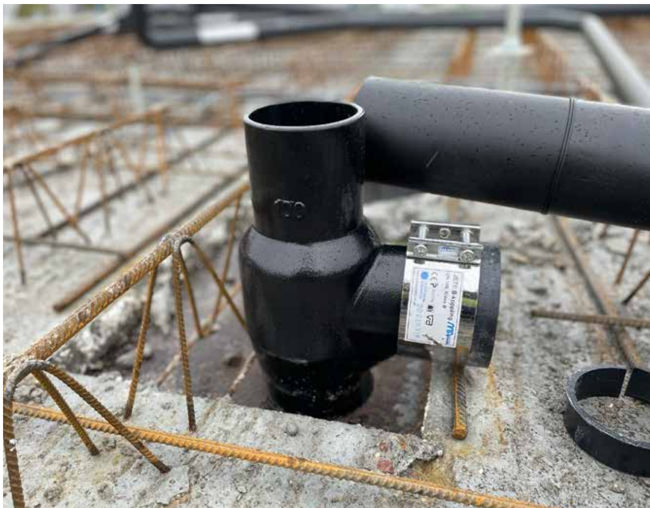
Spiral-rördelar effektiviserar avloppssystemets luftflöde och ökar boendekomforten. Gråjärnet i MA-SYSTEM® gör att spillvattenljudet minimeras.
