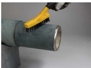
Borsta rent den frilagda ytan med en kraftig stålborste.
