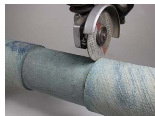
Kapa och fasa därefter röret med de verktyg och maskiner du normalt använder.
