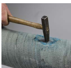
Rensa skadan från lössittande betong.
